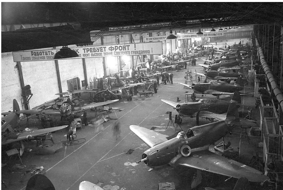
Сборка истребителей Як-1 на авиационном заводе № 292 в городе Саратов; июль 1942-го года (бывший комбайновый завод)
