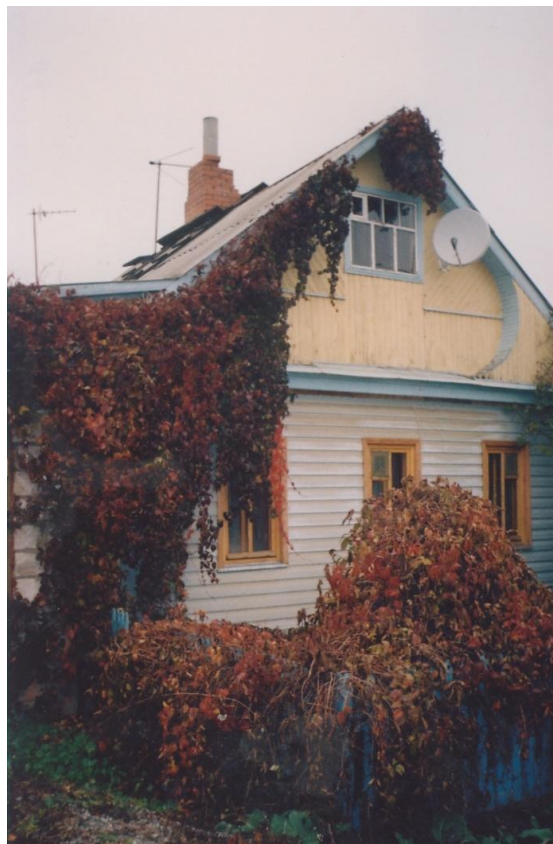
И далее по Орлику, огибающему Пушкарную, за «Зеленстроем» - дома живущих ныне пушкарей и далее коттеджи – пришельцев со стороны. Вот домик пушкаря. Давнишний, придан облик современный
